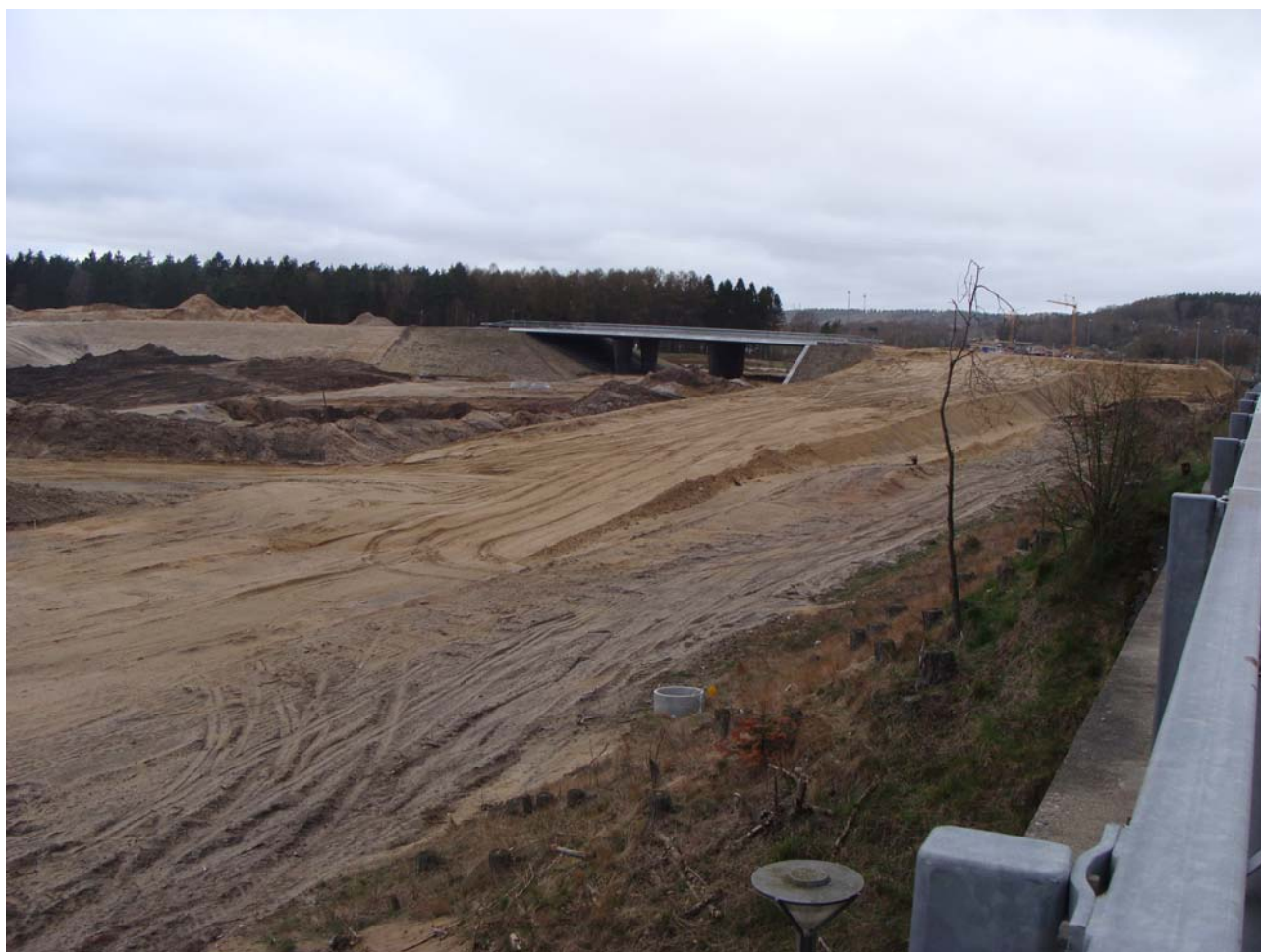
Motorvejsbyggeri ved Silkeborg, april 2014.
