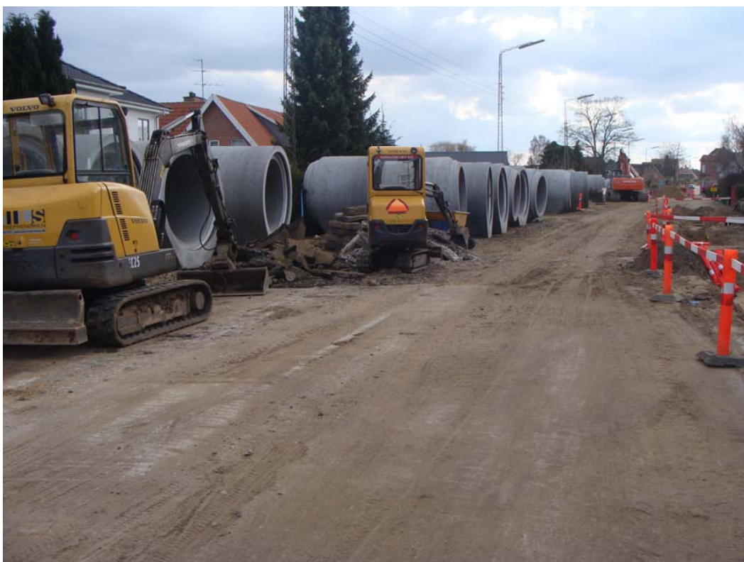
Renovering af vej og regnvandsledning, Viborg Kommune.
