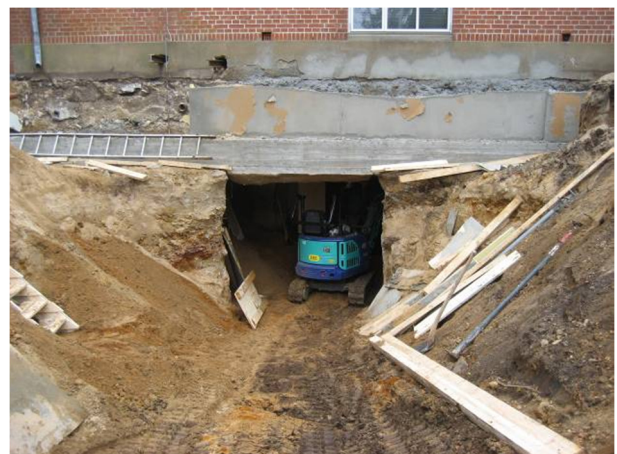
Afgravning under kælder
