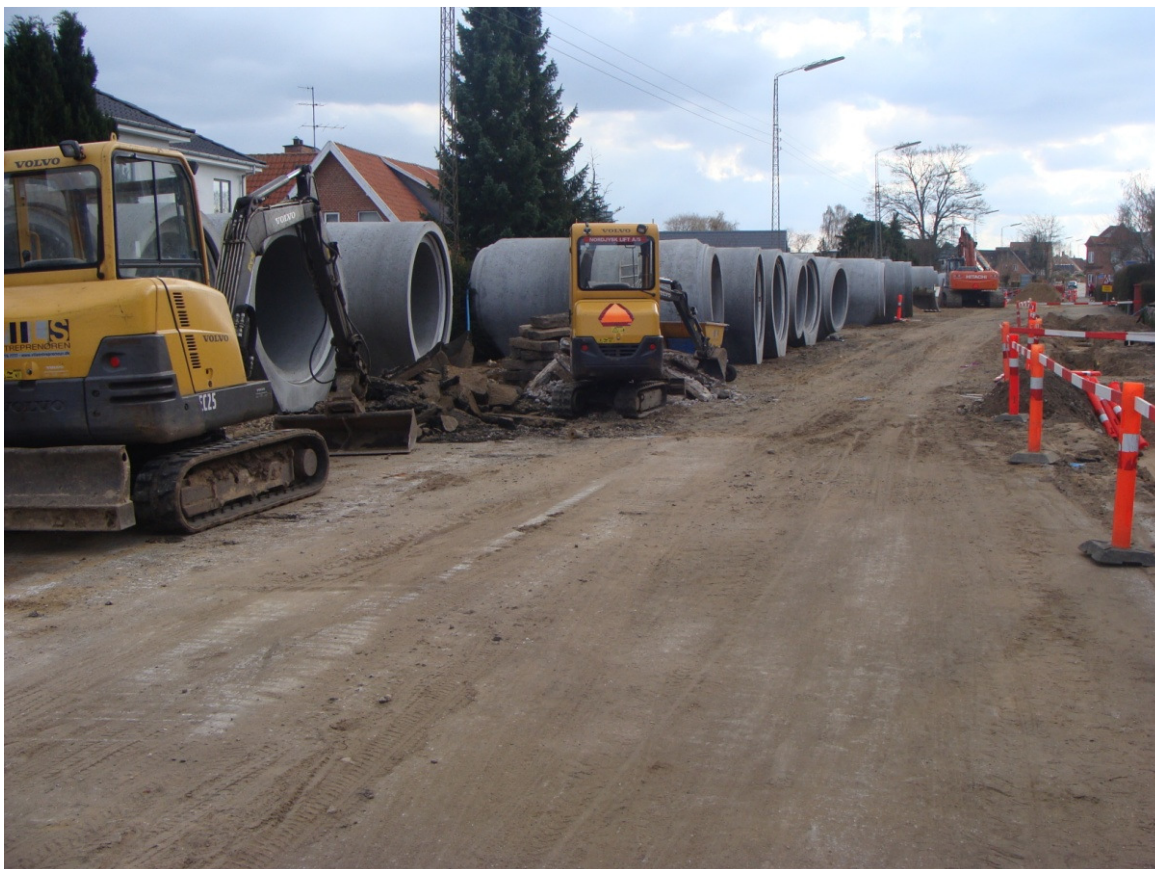
Renovering af vej og regnvandsledning, Viborg Kommune.
