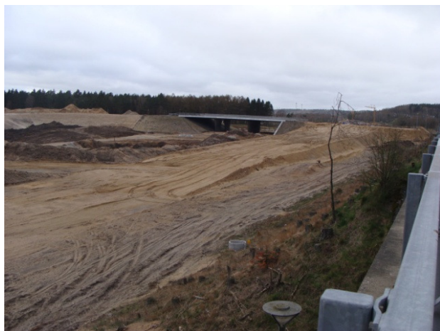
Motorvejsbyggeri ved Silkeborg, april 2014.
