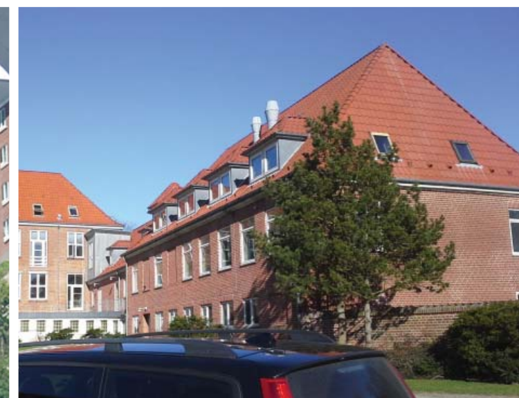
BYGNING 6A &amp; 6B
