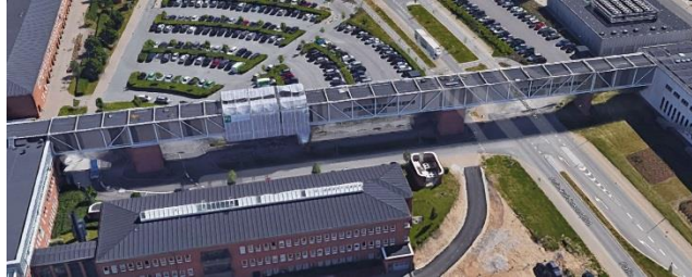
Figur 3.1: Tagflade på logistikbro mellem C-gang og bygning B4.
