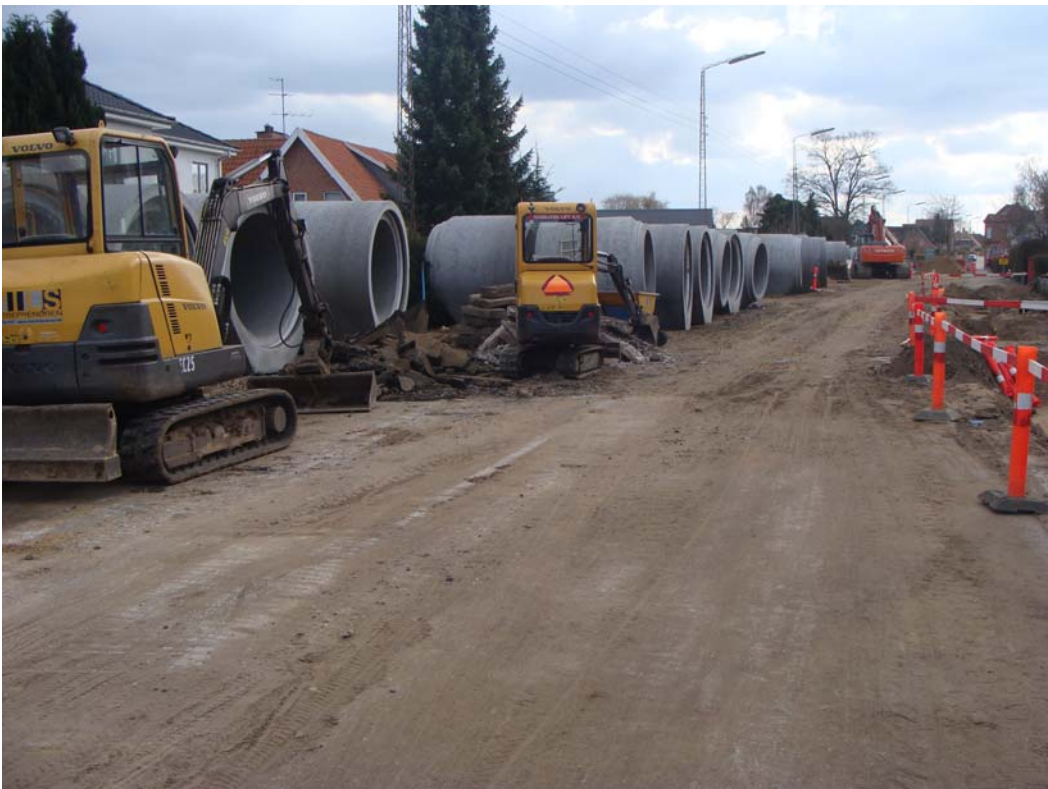
Renovering af vej og regnvandsledning, Viborg Kommune.
