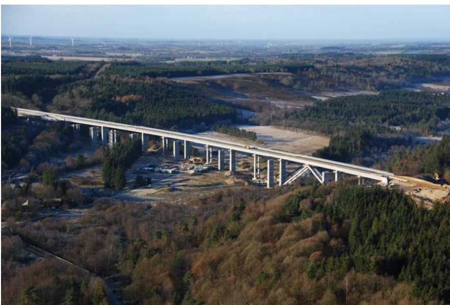
Motorvejsbro ved Funder, Silkeborg Kommune. Kilde: Petri & Betz.
