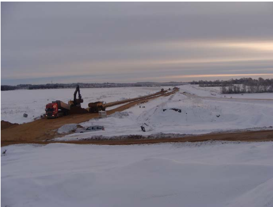
Motorvejsbyggeri ved Pårup, Ikast-Brande Kommune.
