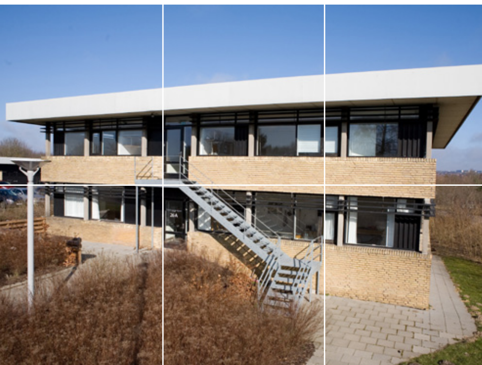
MultifunC Midtjylland blev etableret i Viby J. i en eksisterende bygning, som dog har gennemgået en større renovering før indflytning
