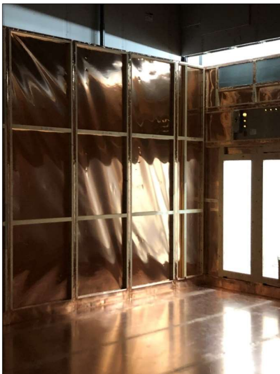
Faraday-bur ved opbygning i råhus, Regionshospitalet Gødstrup.
