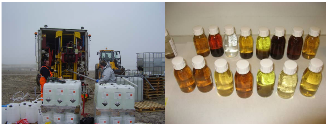
Foto 3 & 4. Til venstre ses dunke med natronlud i forgrunden og borebil i baggrunden. Borebilen udfører en boring til at infiltrere luden i. Til højre ses grundvandsprøver, der viser at der er dannet hydrolyseprodukter med flotte farver allerede få timer efter infiltration af lud.
